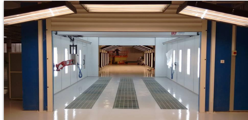
CABINE DE PINTURA
